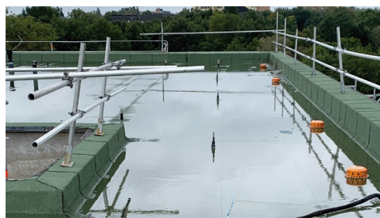
Abbildung 2: Retentionsdach vor Begrünung
